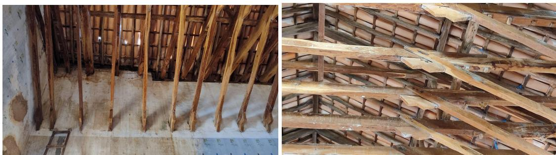
*Danos aos componentes estruturais da cobertura - provavelmente proveniente de infiltrações*
